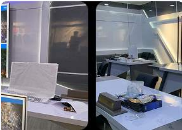
Pemassangan Comand Center JABAR
