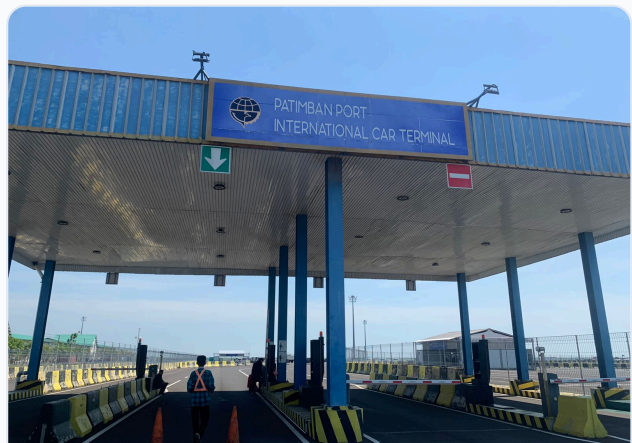
Perawatan dan perbaikan autogate Pelabuhan Patimban
