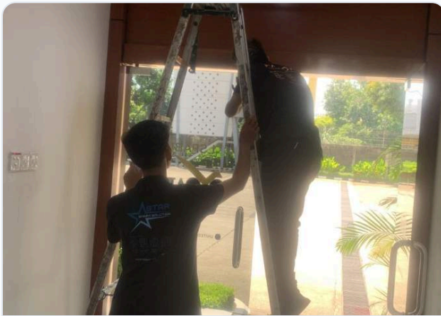
Instalasi RFID di LSP ABI
