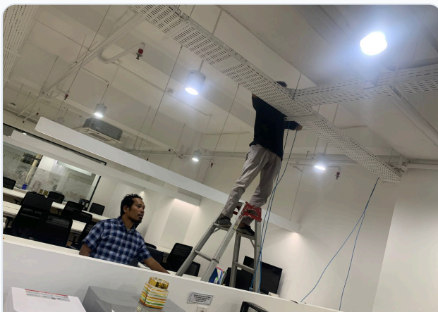
Instalasi dan perawatan Jaringan Internet Pada LSP ABI
